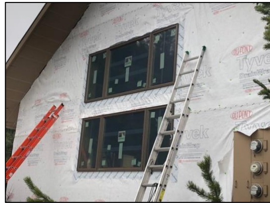
Bldg E1 Unit #8 New Windows
