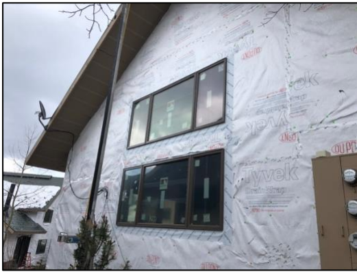
Bldg E3 Unit #24 New Windows
