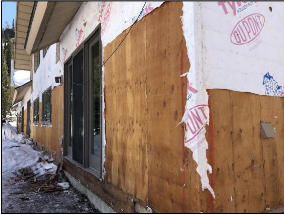
Bldg E3 North Side
