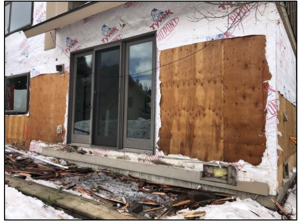
Bldg E3 North Side Unit #24
