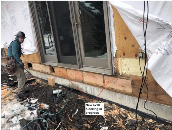
Bldg E3 Unit #25 Blocking
