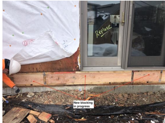
Bldg E3 Unit #24 Blocking
