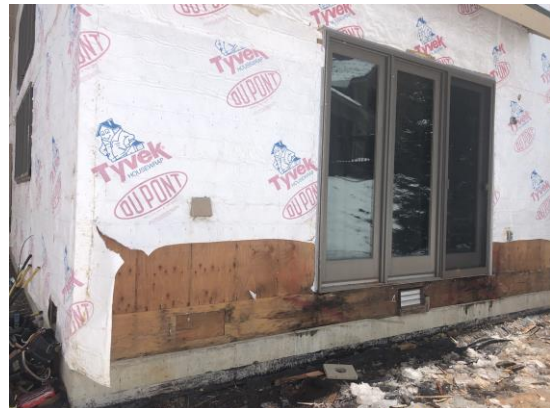
Bldg E4 Unit #28 Patio Door
