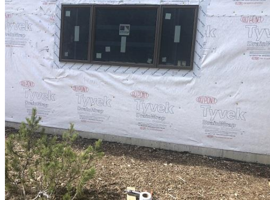
Bldg E3 Unit #31
