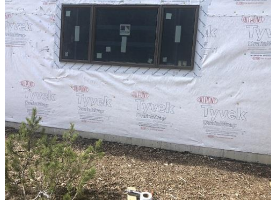
Bldg E3 Unit #31
