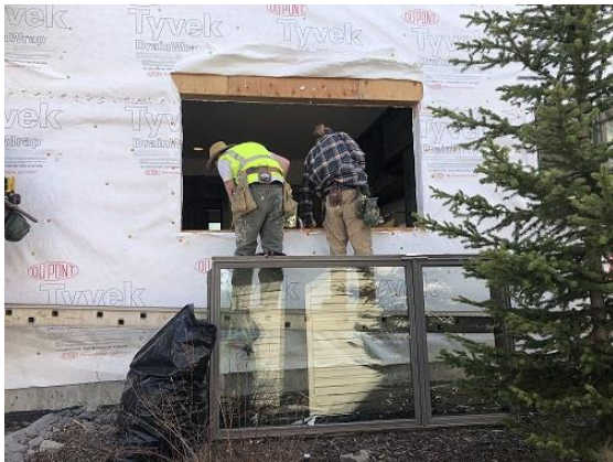
Bldg E3 Unit #31
