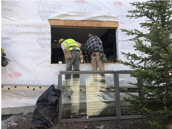
Bldg E3 Unit #31
