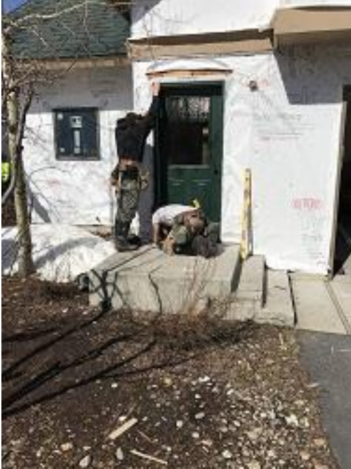
Bldg E2 Unit 23 Front Door
