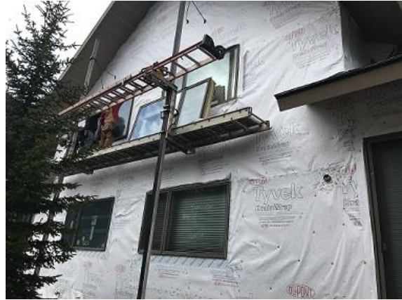
Bldg E3 Unit #27 Lower & Upper Windows
