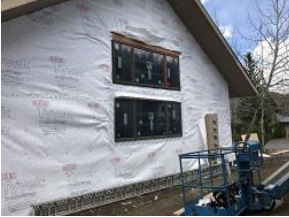
Bldg E2 Unit #23 Upper Side Window
