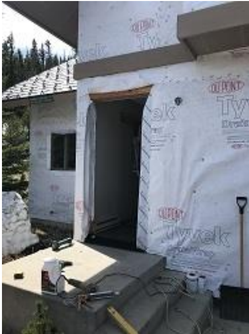
Bldg E1 Unit #8 Front Door Opening
