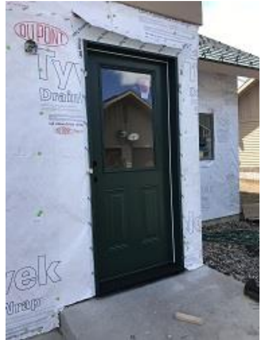
Bldg E1 Unit 11 Front Door
