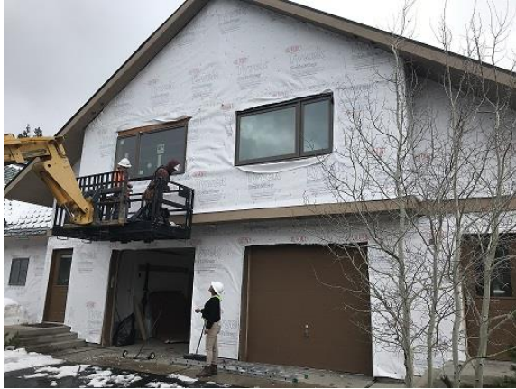
Bldg E1 Unit #10 Window Over Garage
