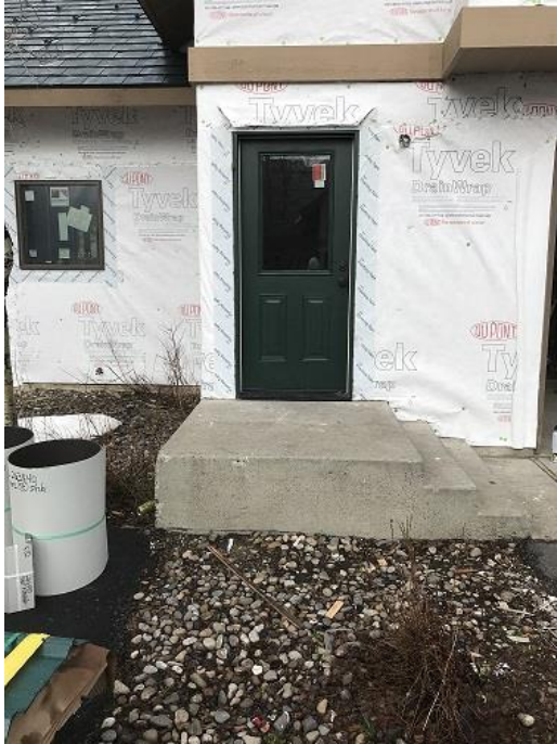
Bldg E4 Unit #31 Front Door & Hardware
