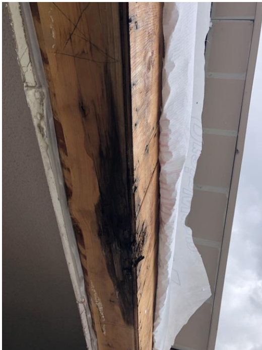
Bldg E3 Units #25 Window Head
