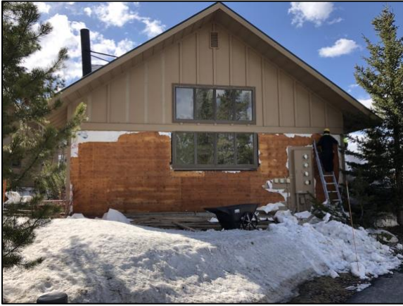
Bldg E1 East Side Siding Removal
