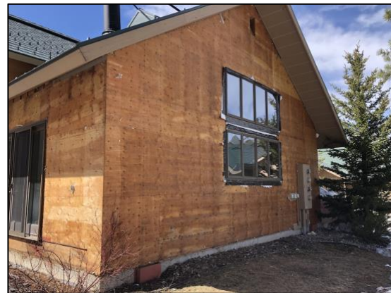
Bldg E1 Unit #8 North Side
