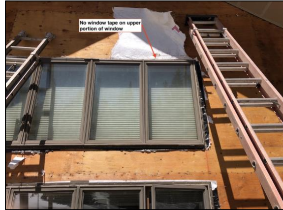
Bldg E4 Unit #31 Upper Wdw
