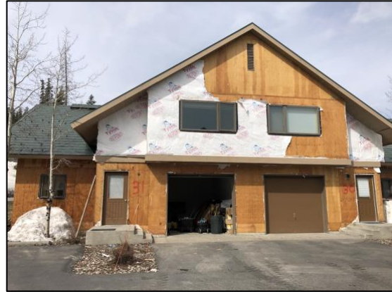
Bldg E4 Units #30 & 31
