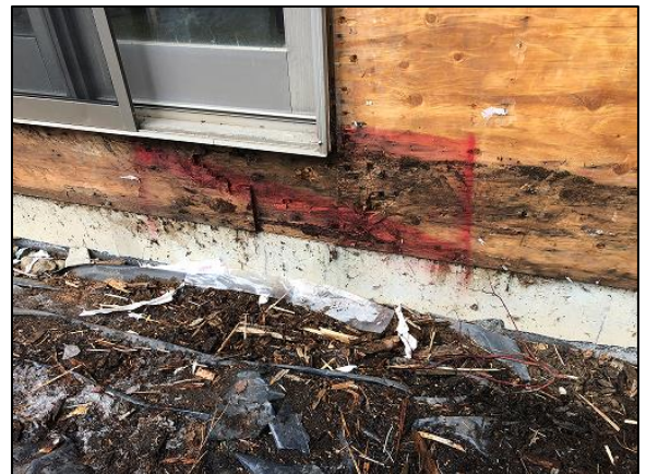
Bldg E3 Unit #9 Deck Location
