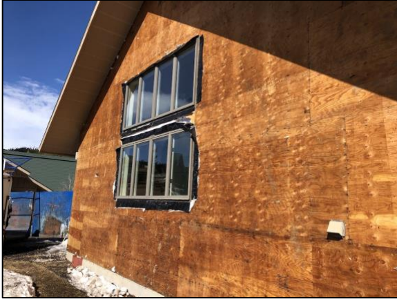
Bldg E1 Unit #11 West Side
