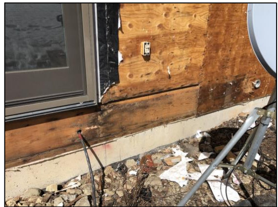
Bldg E1 Unit #11 Area Under Patio Door
