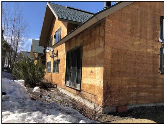
Bldg E1 Unit #8 East Side
