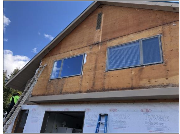
Bldg E1 Unit #8 Siding Removal
