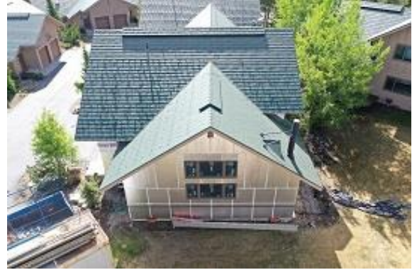
Bldg E1 South Side
