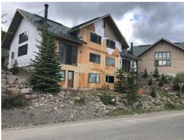
Bldg F1 West Side Sheathing Complete Pic 1
