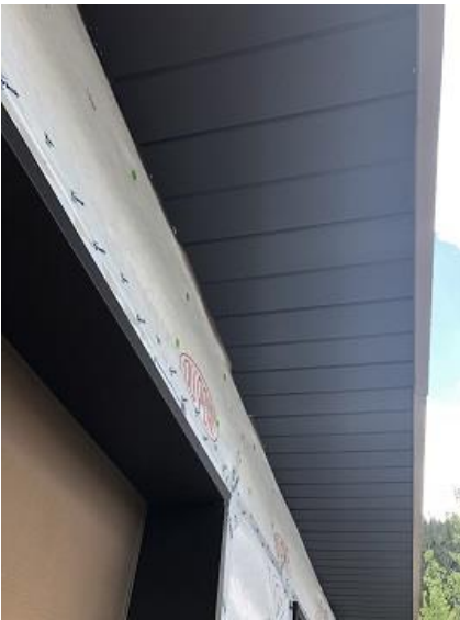
Bldg E3 Soffit
