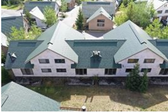
Bldg E2 South Side
