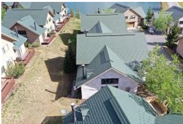
Bldg E2 East Side
