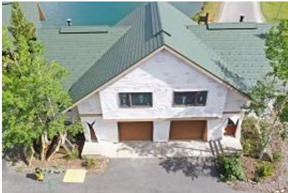
Bldg F1 East Side
