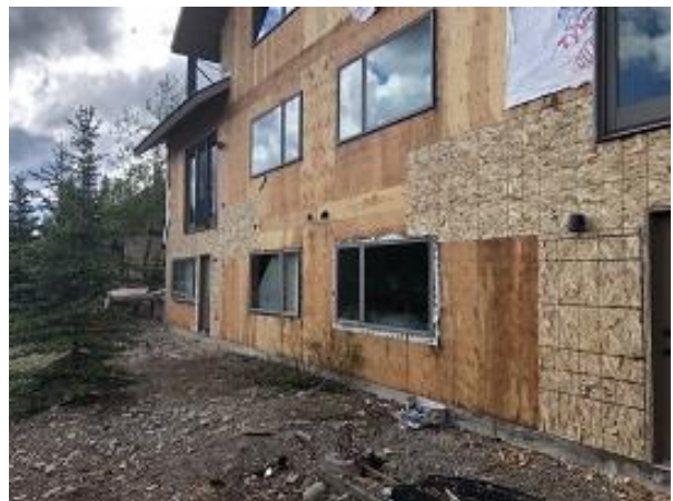
Bldg F1 West Side Sheathing Complete Pic 2
