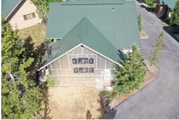
Bldg E1 North Side
