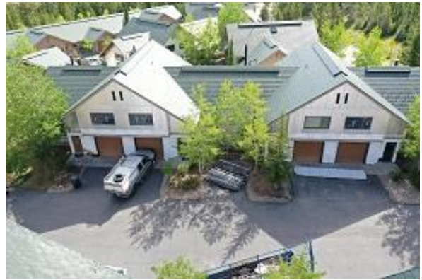
Bldg E3 South Side
