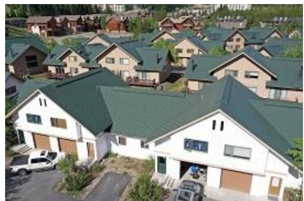
Bldg E2 North Side
