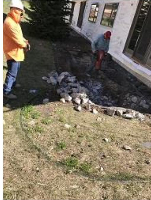
Buidling E2 Unit 23 Deck Foundation Demo
