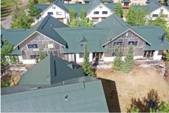
Bldg E3 North Side
