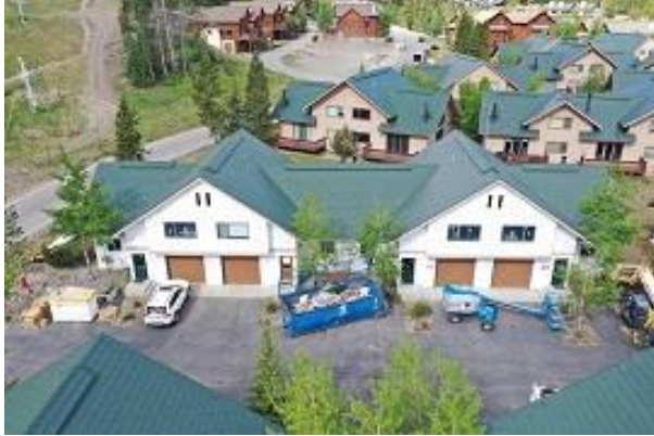
Bldg E4 North Side
