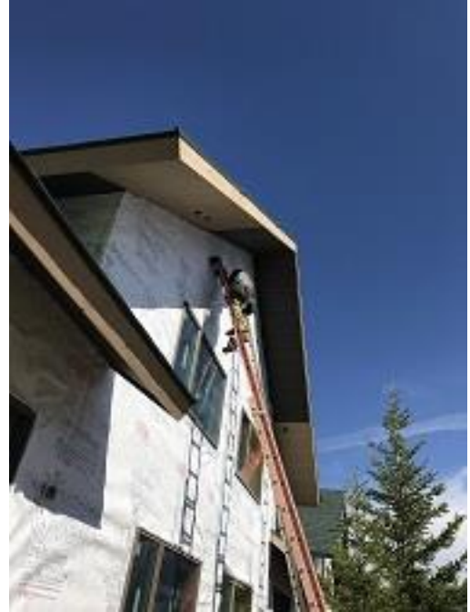
Bldg E3 Unit #26 & 27 Rear Gable Soffit
