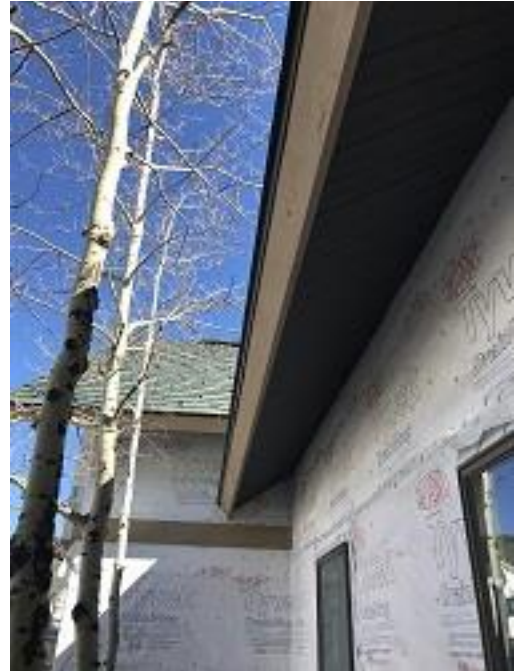
Bldg E3 Unit #26 & 27 Soffit
