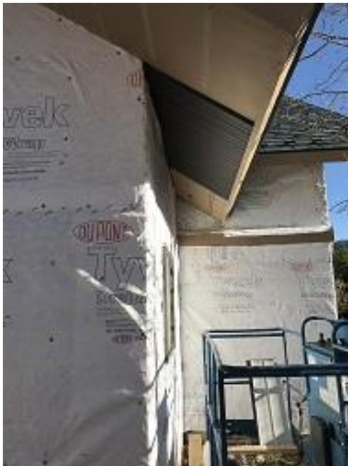
Bldg E2 Unit #23 Front Soffit
