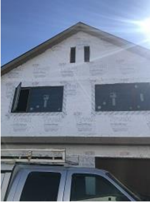
Bldg E3 Unit #24 & 25 Gable Vents
