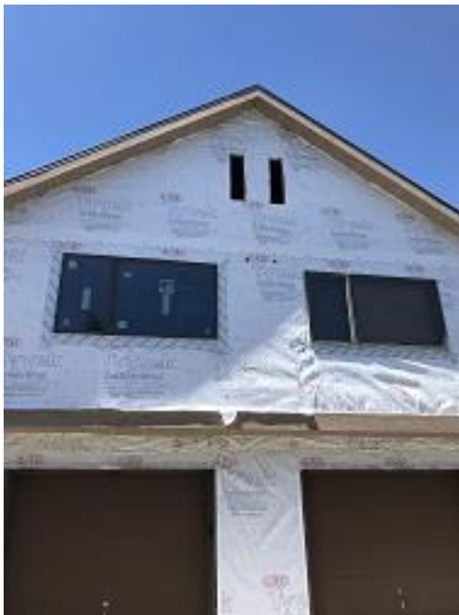
Bldg E2 Unit #20 & 21 Gable Vents
