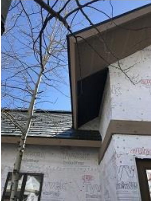
Bldg E3 Unit #26 Soffit
