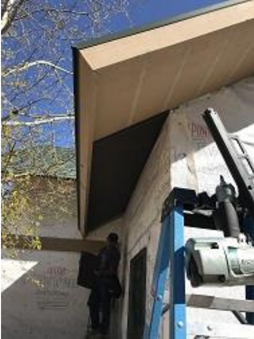
Bldg E3 Unit #27 Front Soffit
