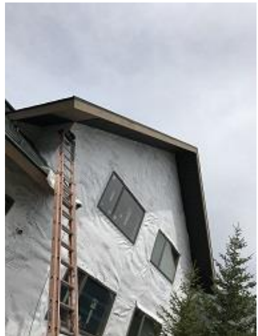
Bldg E3 Unit #24 & 25 Gable Soffit
