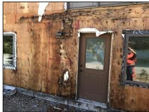
Bldg F1 Unit #17 Rear Lower Siding Demo
