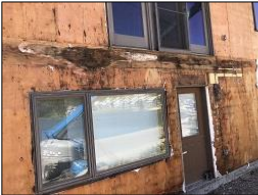
Bldg F1 Unit #16 Rear Lower Siding Demo
