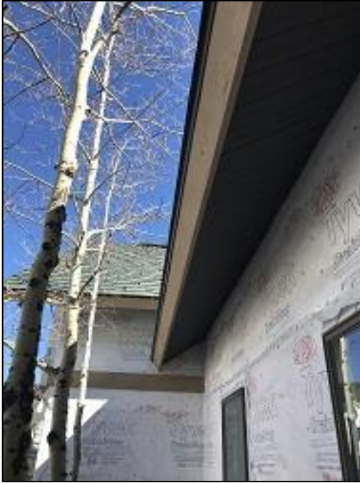
Bldg E3 Unit #26 & #27 Soffit
