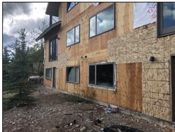
Bldg F1 Unit #16/#17 Sheathing Complete
