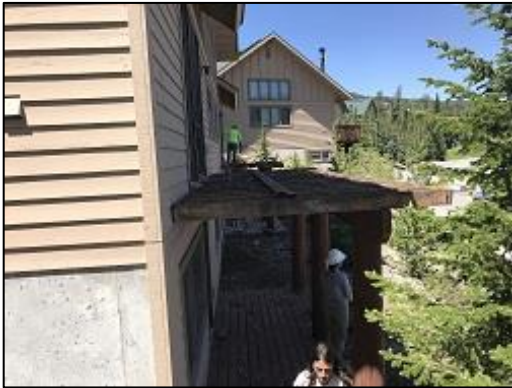
Bldg F1 Unit #16 Deck Demo
