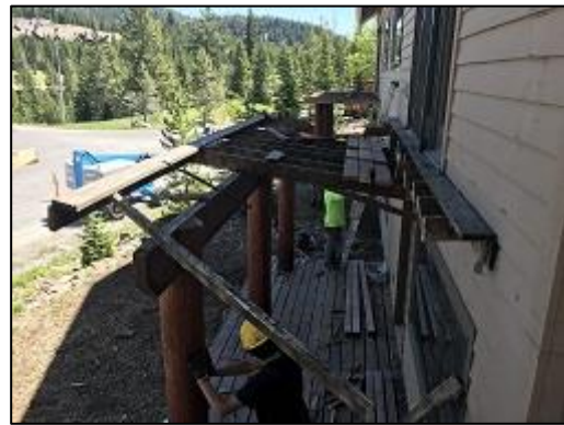
Bldg F1 Unit #17 Deck Demo
