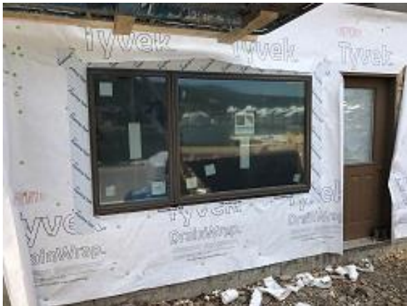
Bldg F1 Unit 16 Basement Left Window Installed
