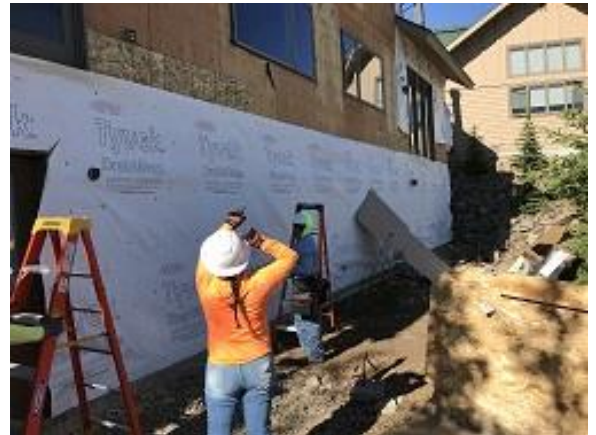
Bldg F1 Unit 16 & 17 Tyvek Install Continued
