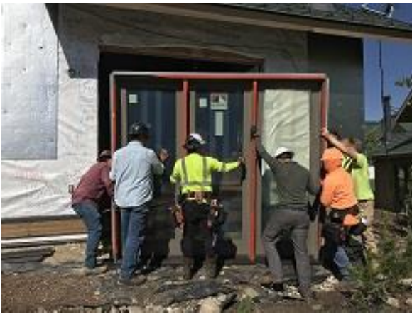
Building E3 Unit 24 Patio Door Installation
