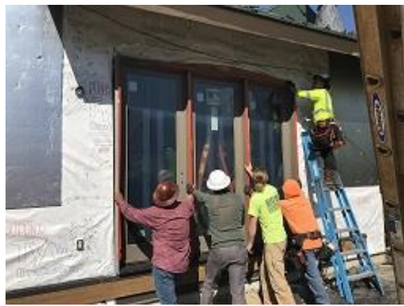
Building E3 Unit 24 Patio Door Installation
