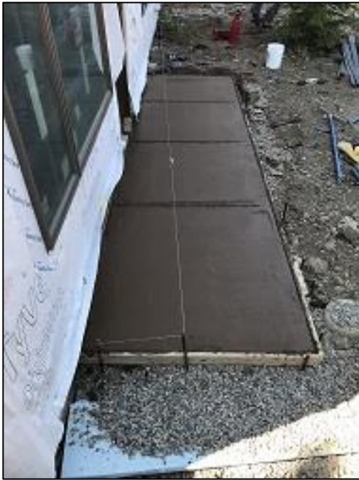
Bldg F1 Units #16 & #17 Concrete Patios Installed
