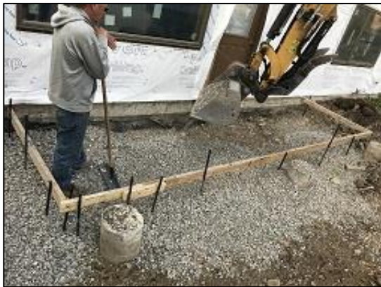
Bldg F1 Unit #16 Concrete Patio Prep
