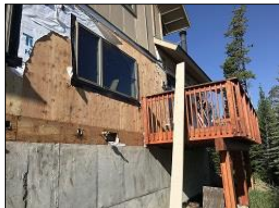
Bldg E7 Unit #52 Siding Demo In Progress
