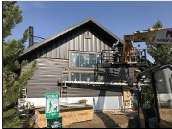
Bldg E1 Unit #8 Board & Batten
