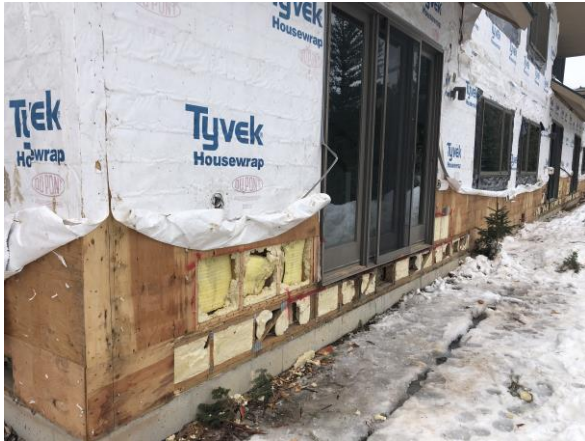
Building E8 Unit 55 Patio Door Sill Plates
