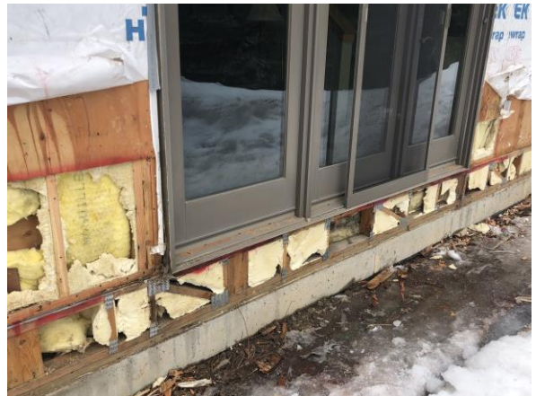
Building E8 Unit 57 Patio Door Sill Plates
